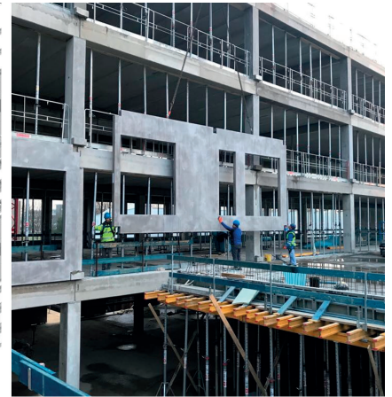
Fertigteile werden gesetzt
